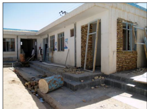
Igangværende renovation af det ambulante afsnit på GDH.
